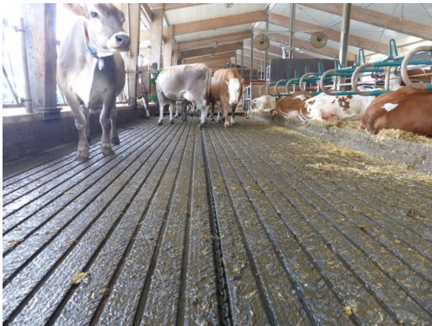
Bild 3: Emissionsmindernde Ausführungen von Laufflächen im Stall sorgen durch Gefälle oder/und Rillen für eine schnelle Trennung von Kot und Harn.
